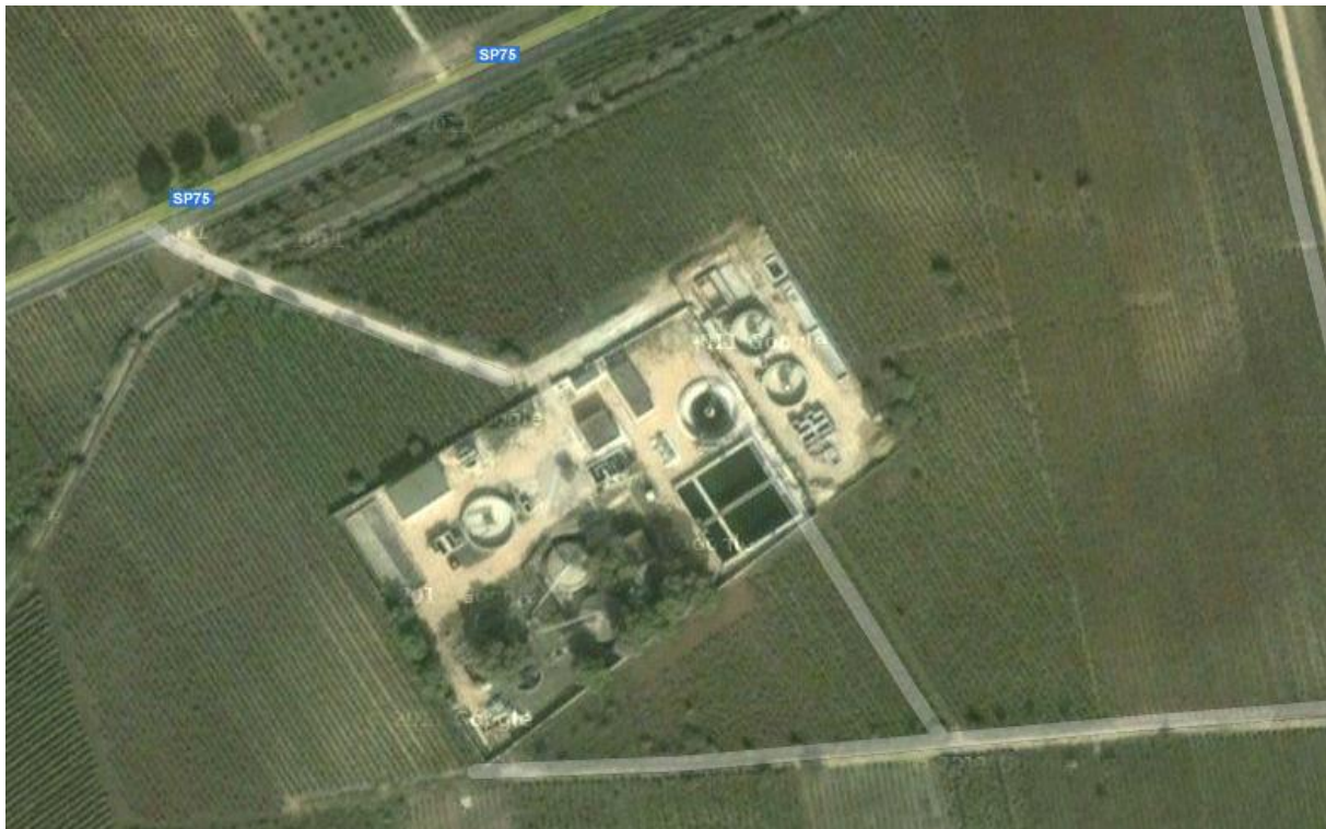
Figura 16: immagine dall'alto dell'impianto di depurazione consortile con affianco l'impianto di affinamento (Fonte:Google Earth)
