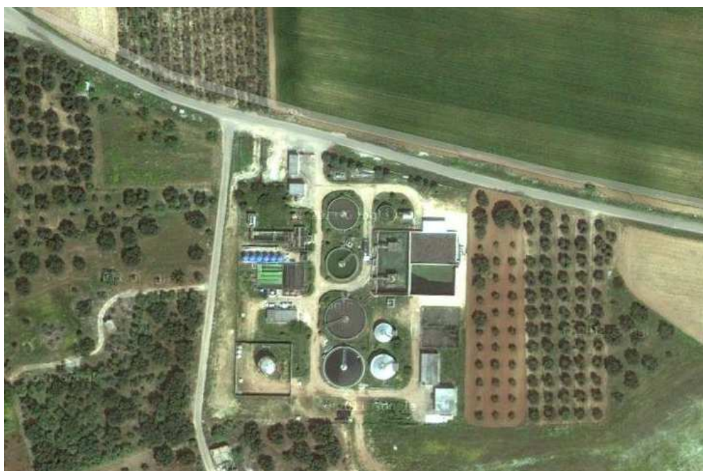
Figura 15: Immagine dell'impianto di depurazione consortile
