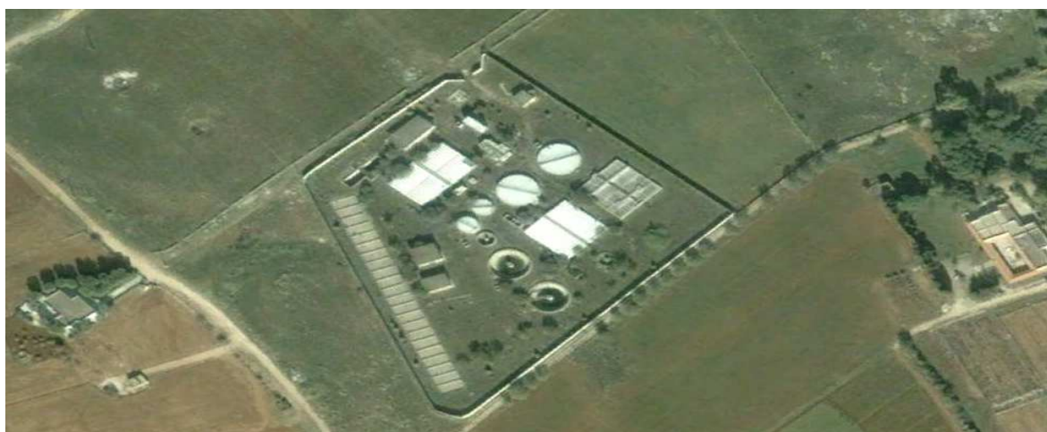
Figura 9: Immagine dell'impianto di depurazione consortile (Fonte: Google Maps)
