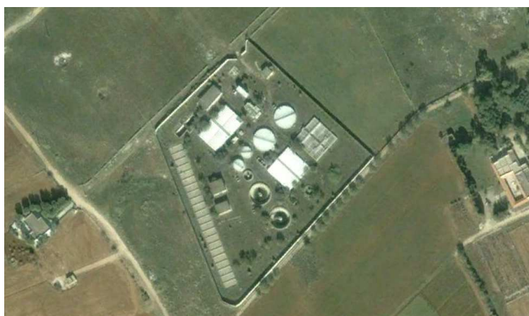
Figura 16: Impianto di depurazione "Porto Cesareo" (Fonte: Google Earth)
