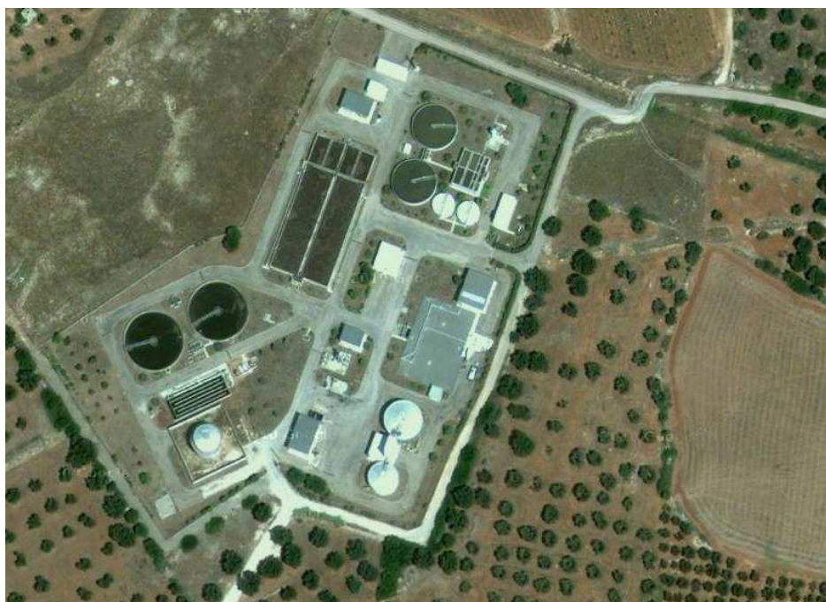
Figura 17: Immagine dall'alto dell'impianto di depurazione consortile (Fonte:Google Earth)
