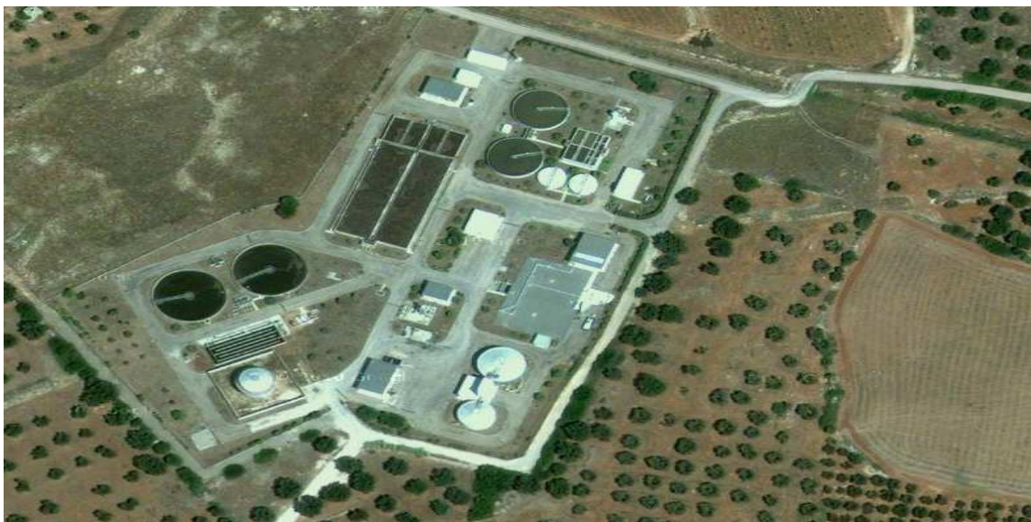
Figura 11: Immagine dell'impianto di depurazione consortile (Fonte: Google Maps)
