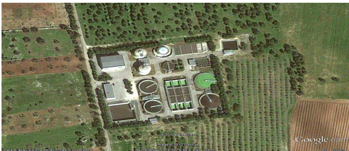
Figura 10: Immagine dell'impianto di depurazione consortile (Fonte: Google Maps)
