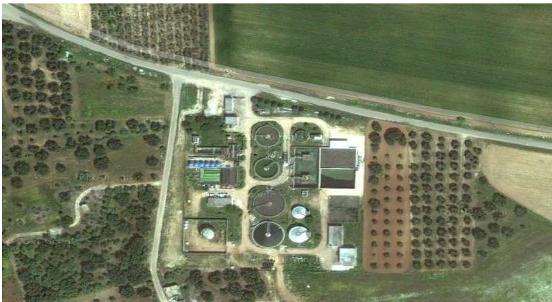
Figura 9: Immagine dell'impianto di depurazione consortile (Fonte: Google Maps)
