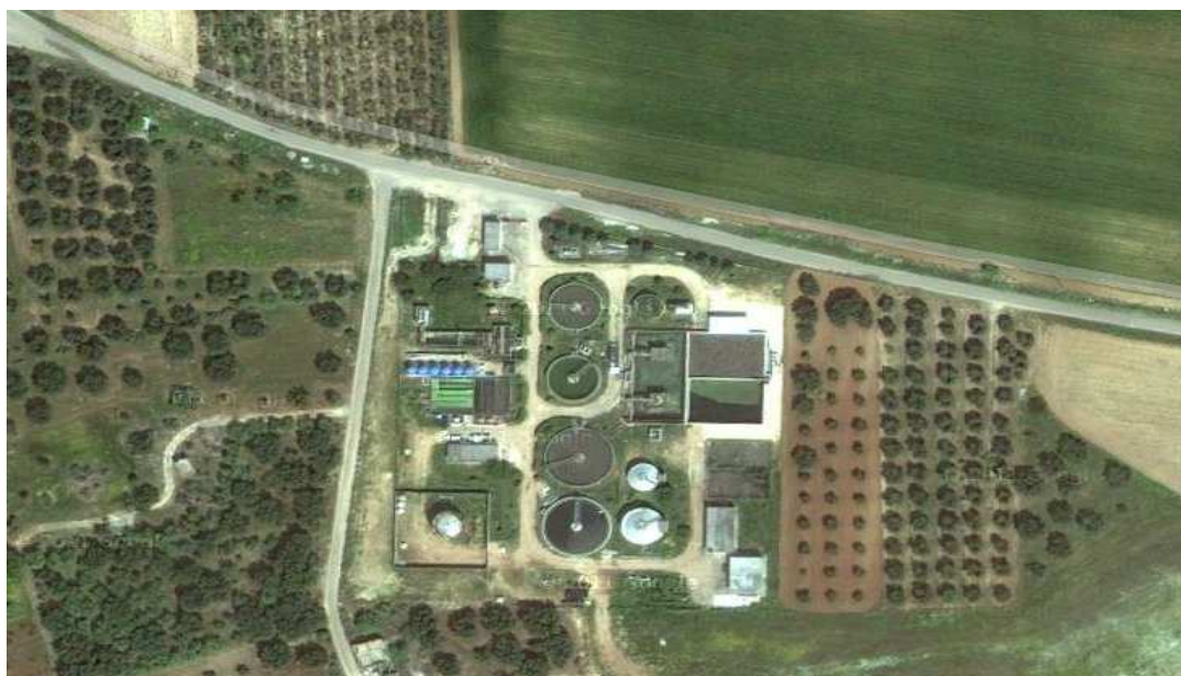
Figura 10: Immagine dell'impianto di depurazione consortile (Fonte: Google Maps)
