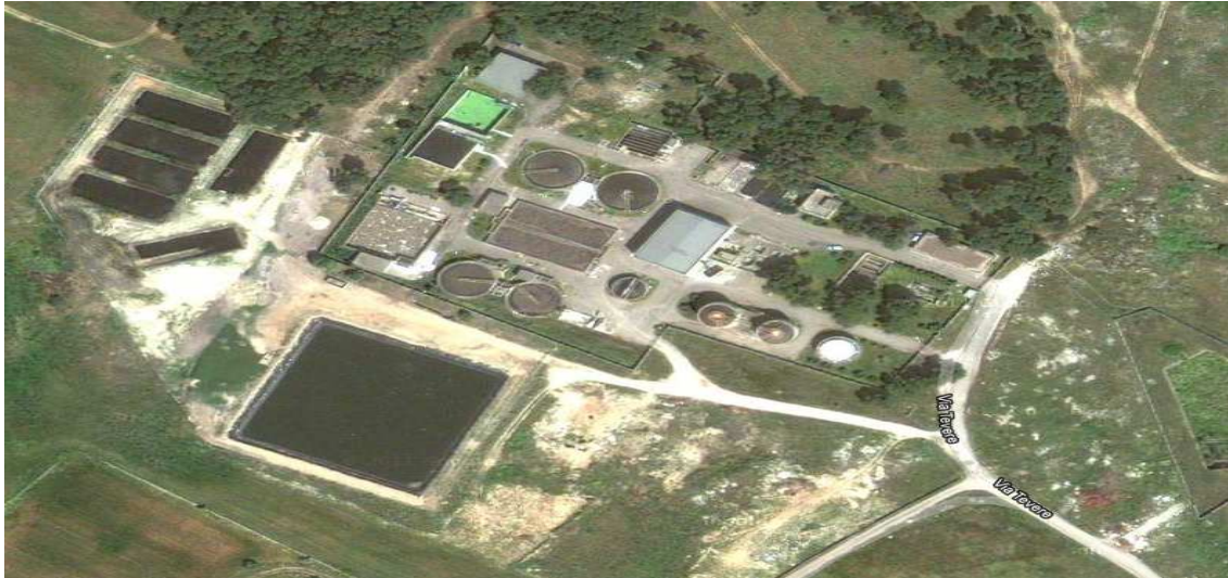
Figura 10: Immagine dell'impianto di depurazione consortile (Fonte: Google Maps)
