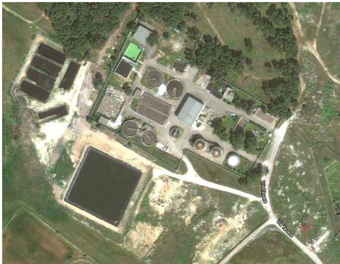
Figura 3: immagine aerea del depuratore di San Cesario di Lecce
